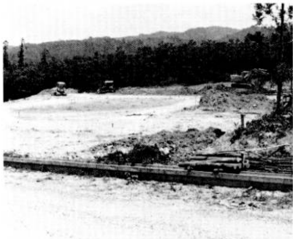
西山に建設中の畜産広場
