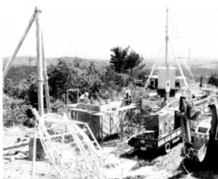
太平山に建設中の民放テレビ中継局
