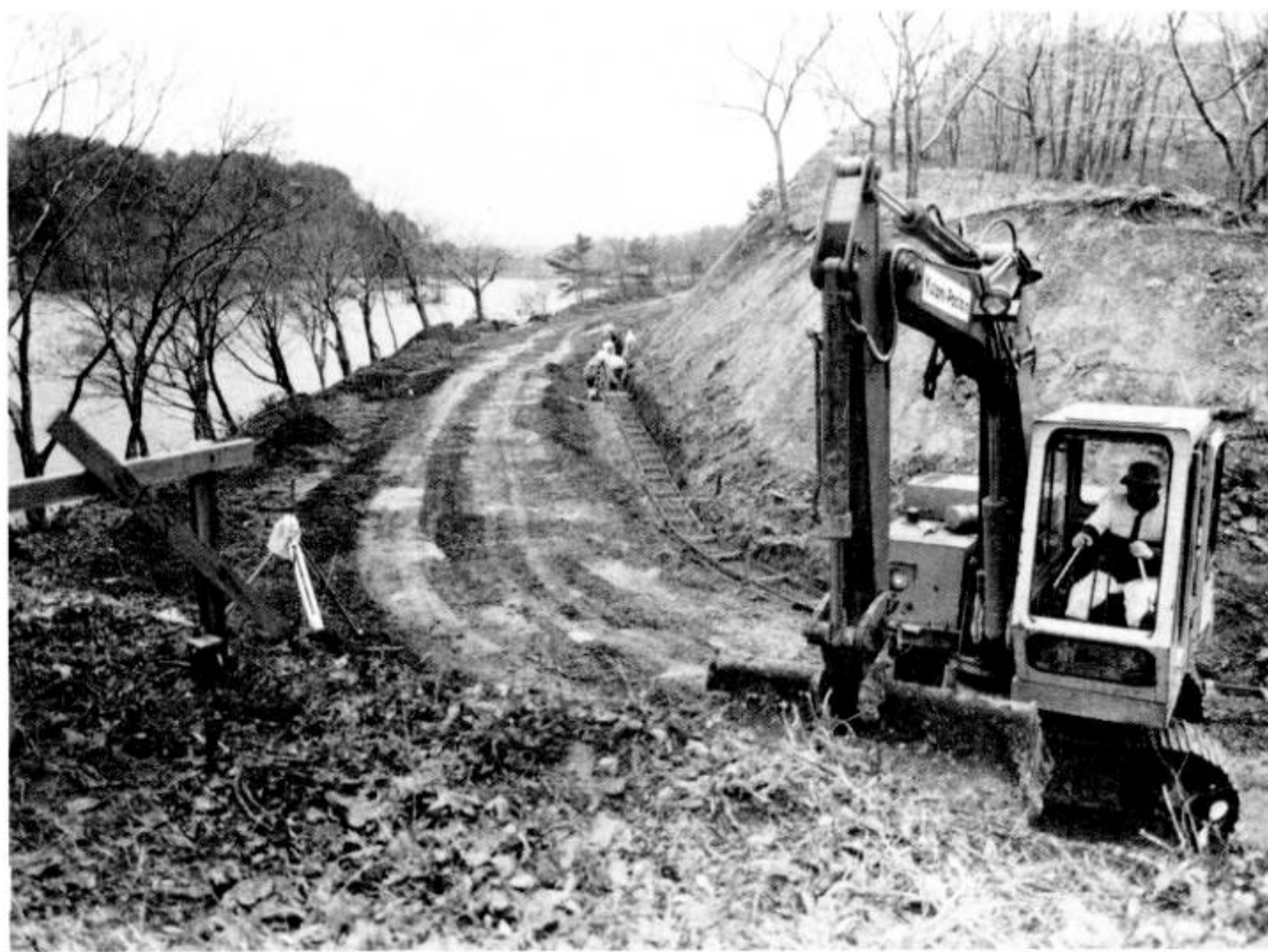
団体営農道で新規に改良が始められた深山線(八塩ダム付近)
