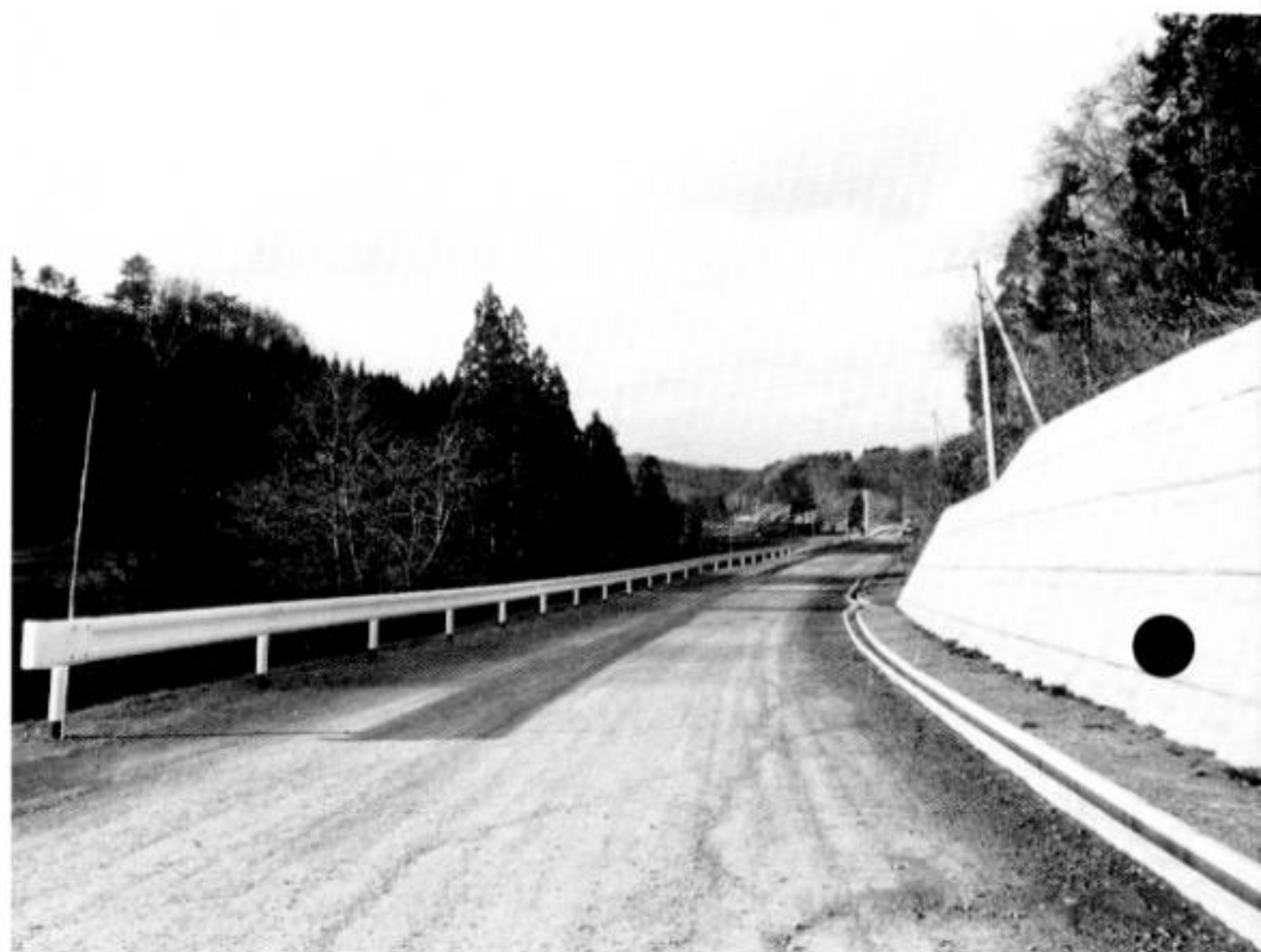
難所の擁壁工事が完成、来年度舗装される県道山崎鴻屋十字線松沢地内
