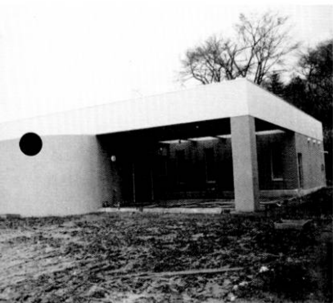
今月中に完成する袖山地区多目的研修施設
