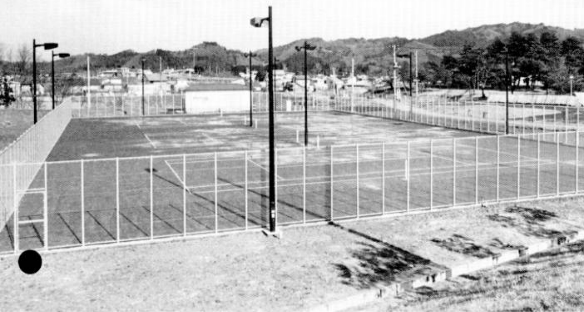
完成した夜間照明付テニスコート
