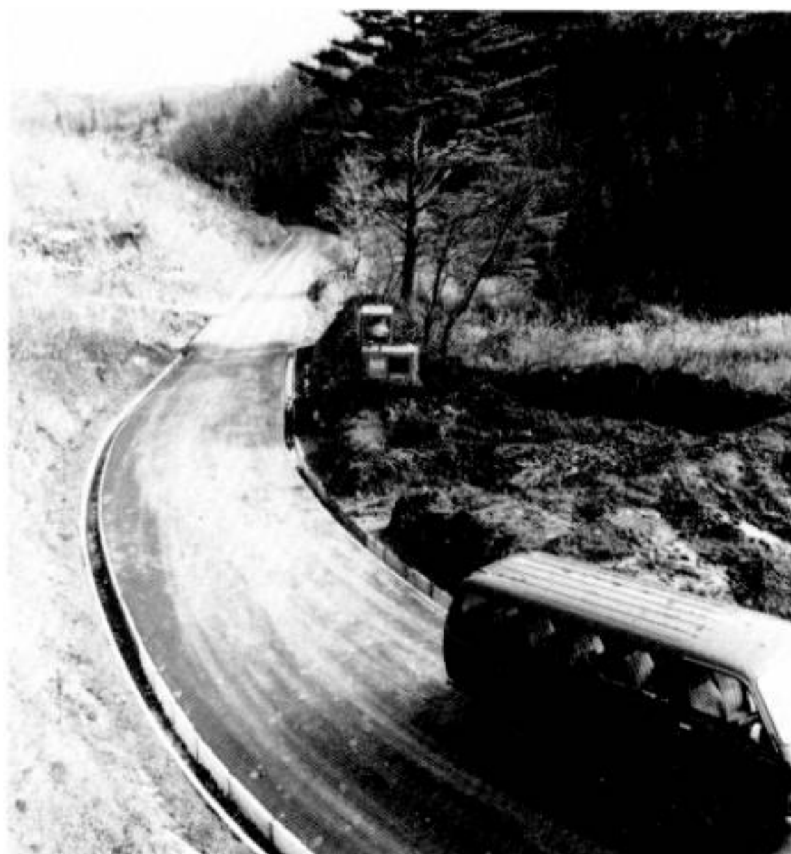
完工した林道ボツメキ線の舗装
