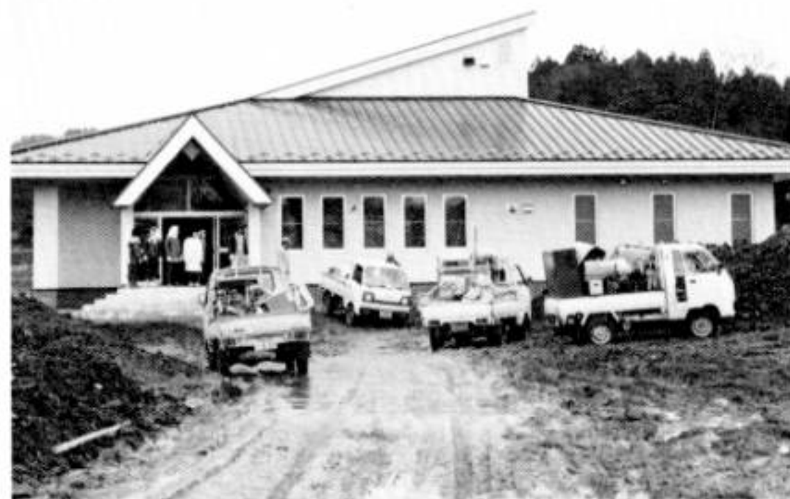
完成したみどり保育園々舎 (父母の会々員らによる移転作業・11月23日)
