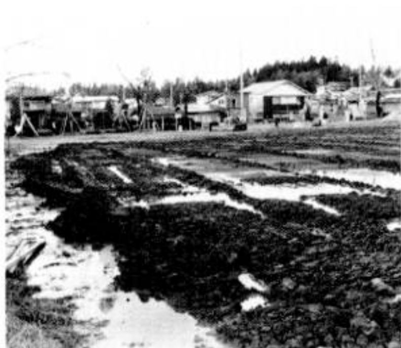
整備中の老方地区コミュニティグラウンド
