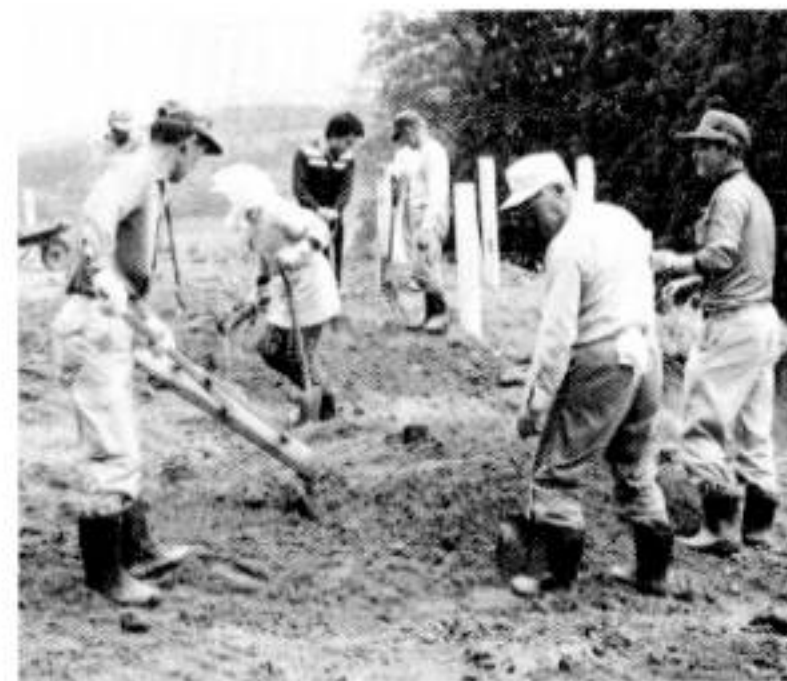
自治会員が総出した整地作業
