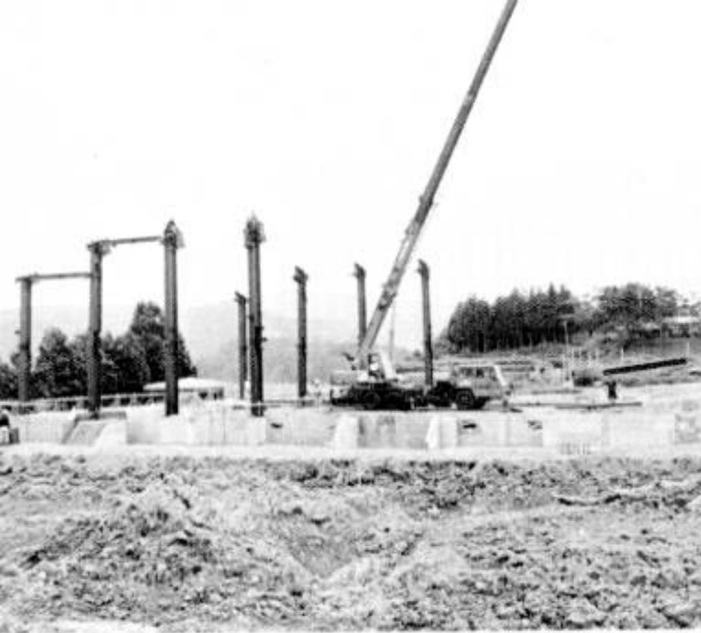
体育館建設工事
