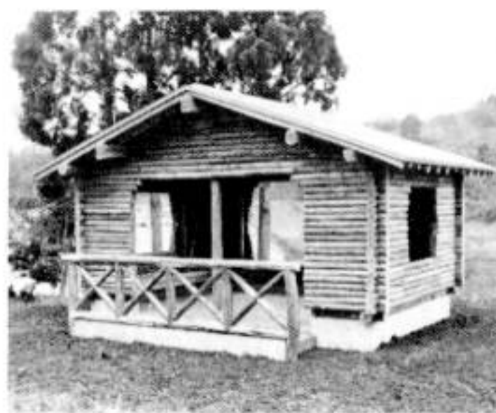
町民いこいの森に完成した休憩所
