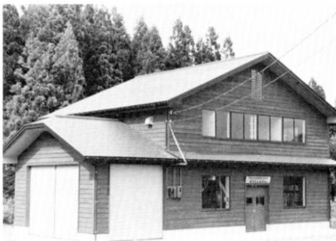
4月から稼動している林産物処理加工施設
