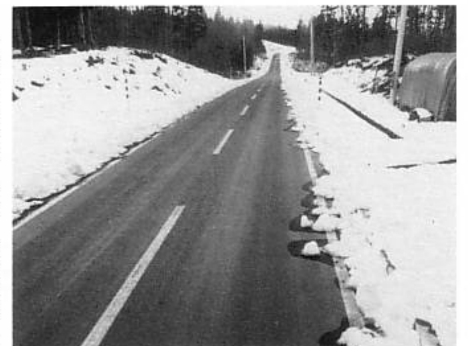
舗装が完成した西山線
