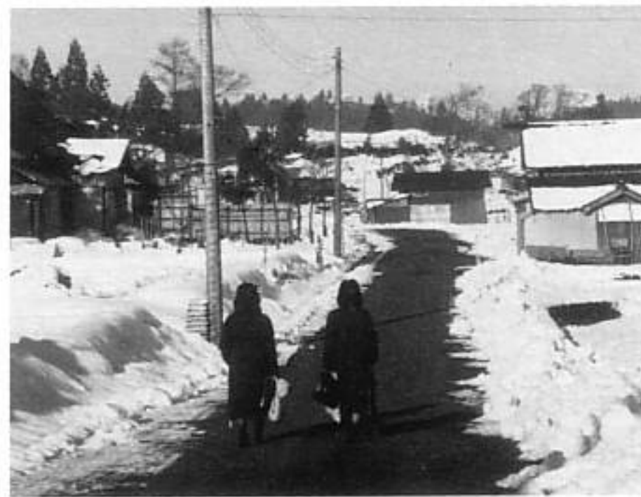
舗装が完成した片越山本線
