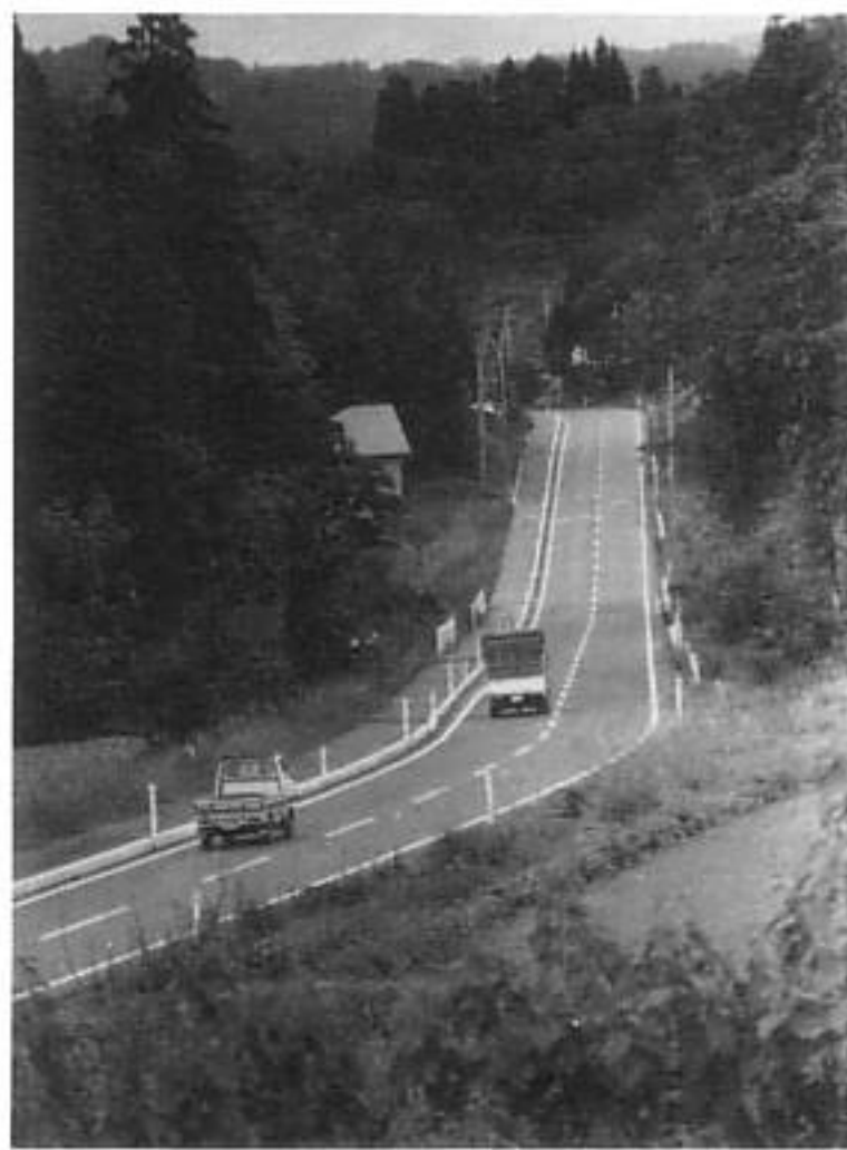
舗装が完成した町道西山線
