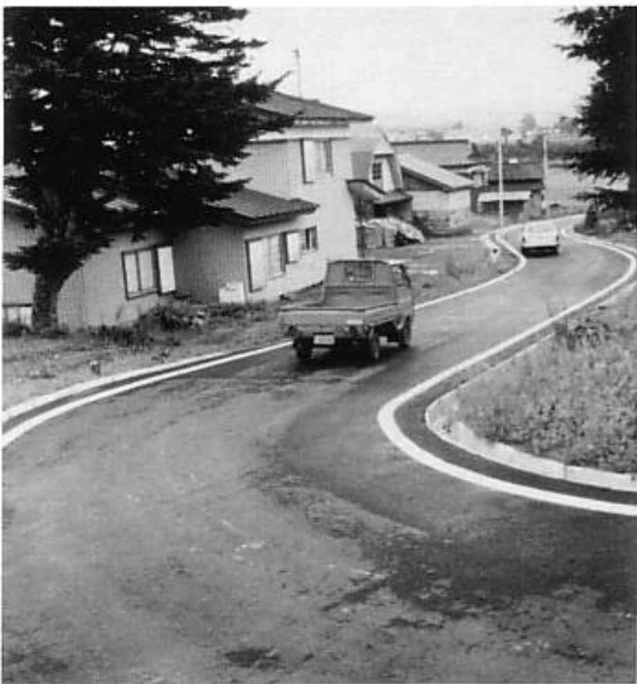
完成した上里地内の集落道・上里線
