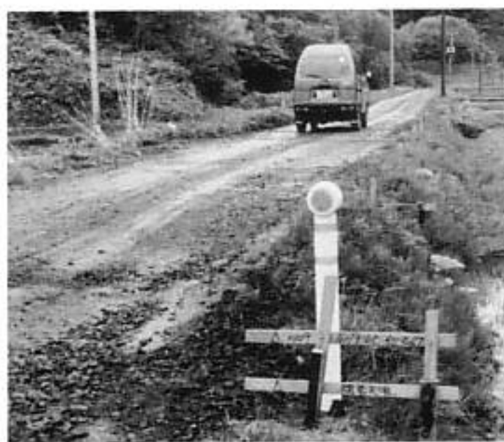
請負契約の締結によって工事が進められる沼地内の町道金山線
