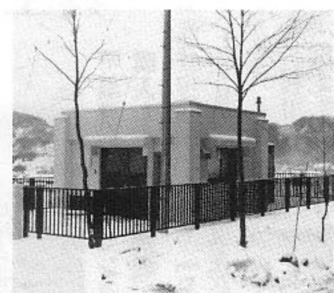
下吹に建設された送水ポンプ場
