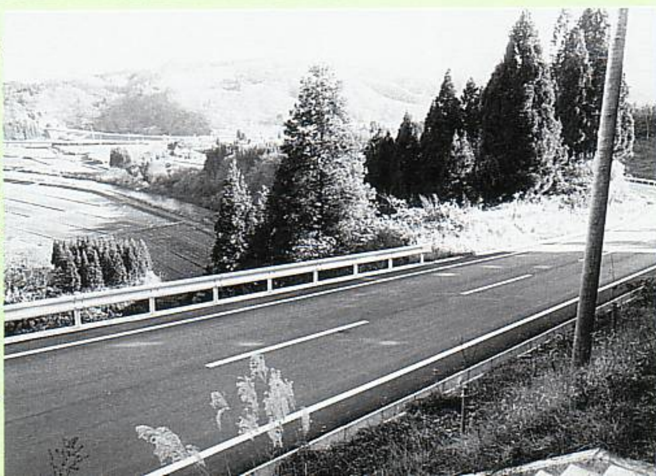
▶ 完工した県道楢淵横渡線・横渡り黒沢トンネル間
