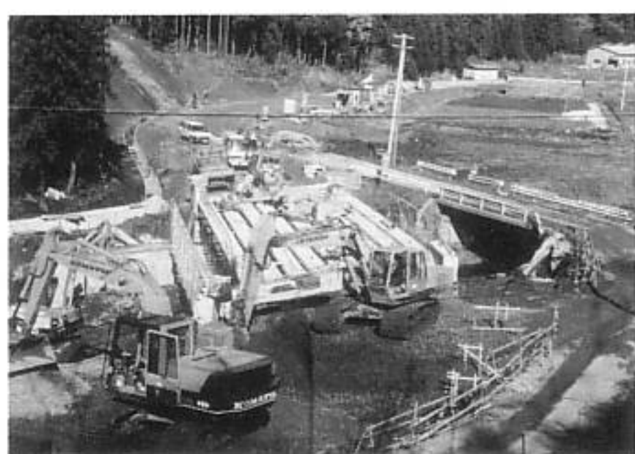
工事中の田屋橋
