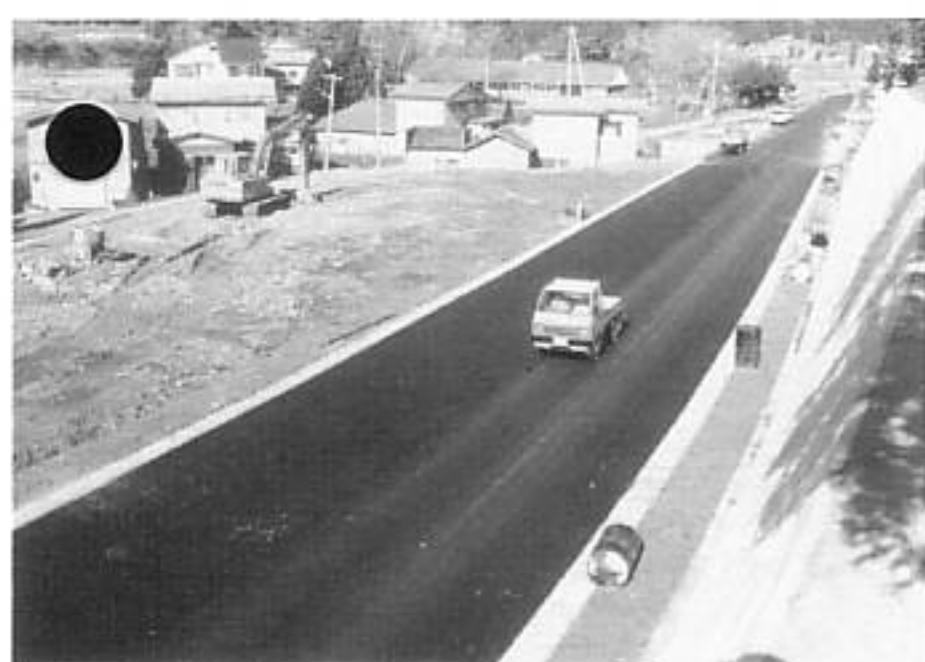
完成した田代地内の県道
