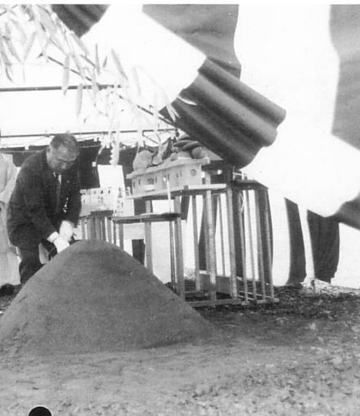
野球場の建設はじまる（写真はスタンド工事の地鎮祭・9/5）
