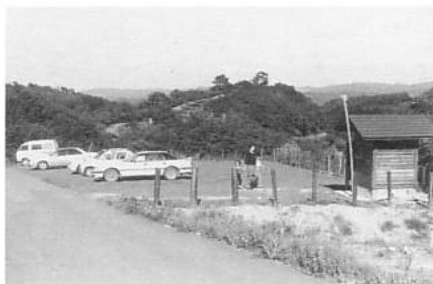
利用者に喜ばれている、ボツメキ水源池に完成した駐車場とトイレ
