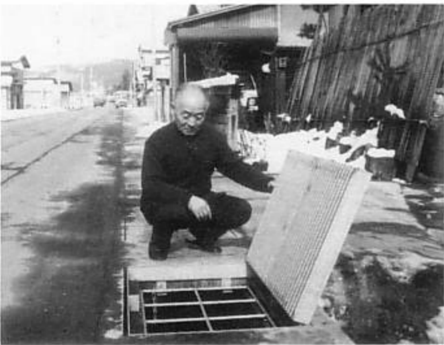
完成した流雪溝(下小路・1/26撮影)
