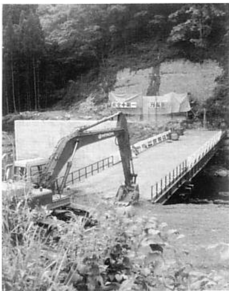
トンネル掘削のため奥ヶ沢地内で進められている架橋工事
