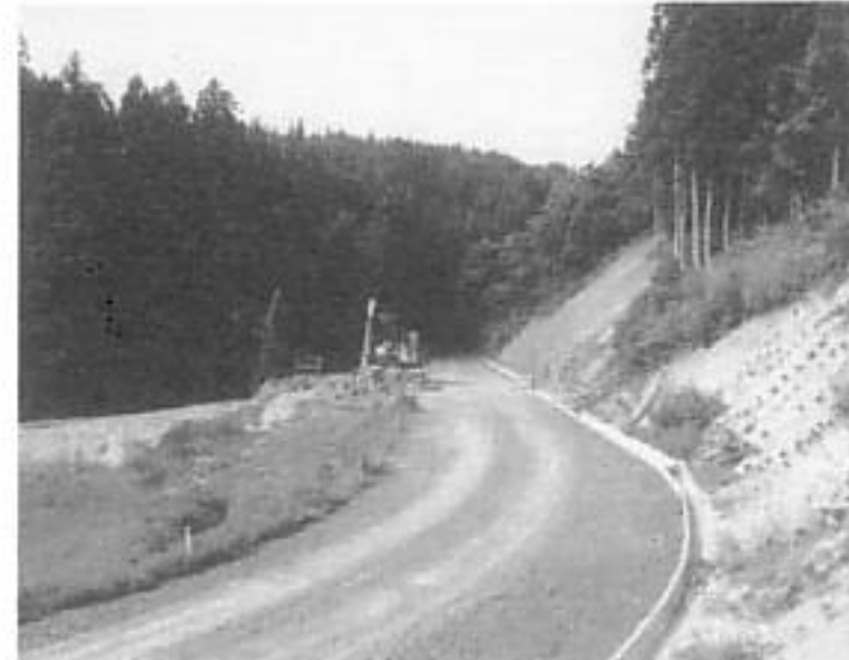
団体営農道整備事業坪倉地区として工事中の坪倉線
