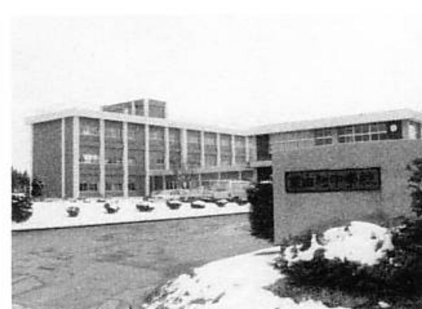
年内に改造工事が完成する東由利中学校
