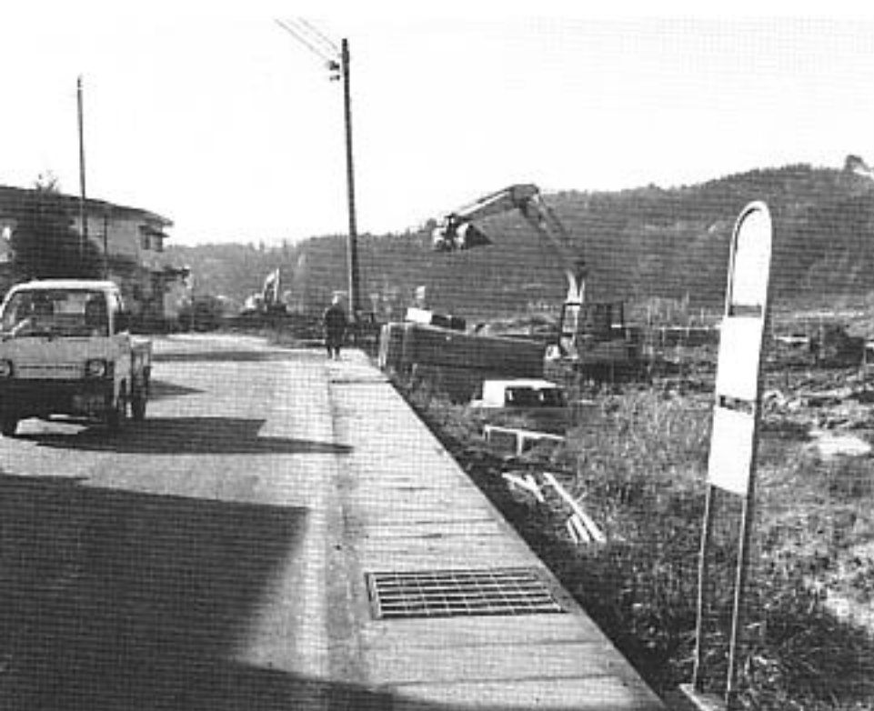
改良工事中の県道仁賀保矢島館合線・須郷田地内
