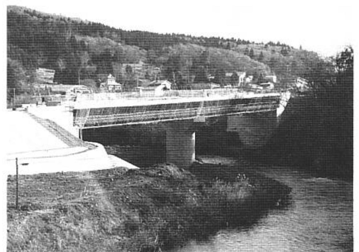
年度内に完成予定の国道107号新田向橋
