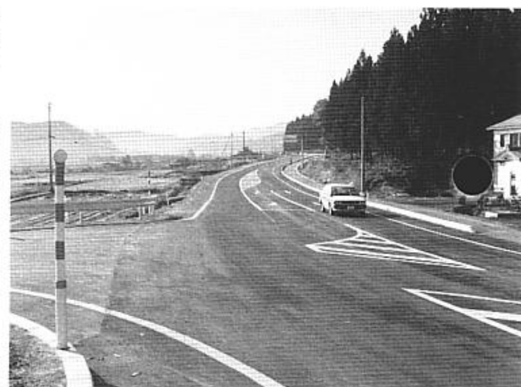
町道・須郷田跡見坂線は今年跡見坂地内の530mを舗装
