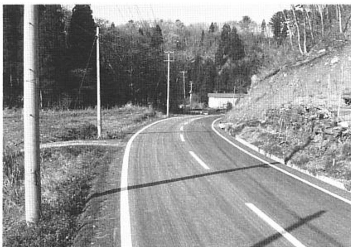
八沢木線(高村)は集落までの舗装が完成
