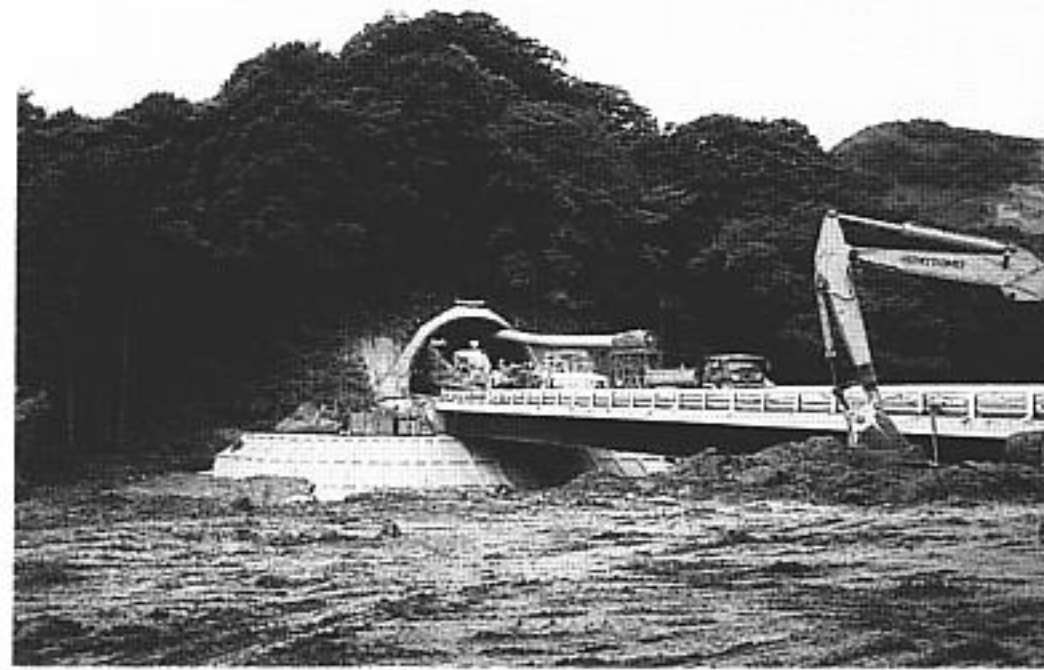
掘削が始まった奥ヶ沢1号トンネル（仮称）
