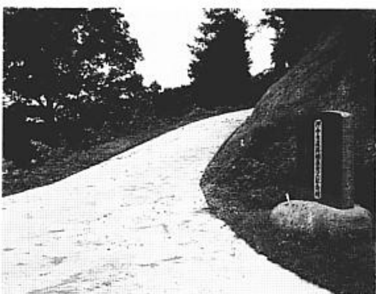
小野仁助氏の寄附で立派に舗装が完成した下吹地区内の作業道
