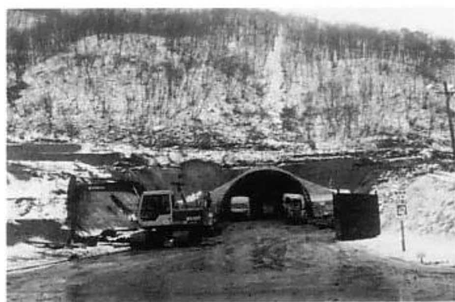
掘削が始まった二号トンネル(仮称)
