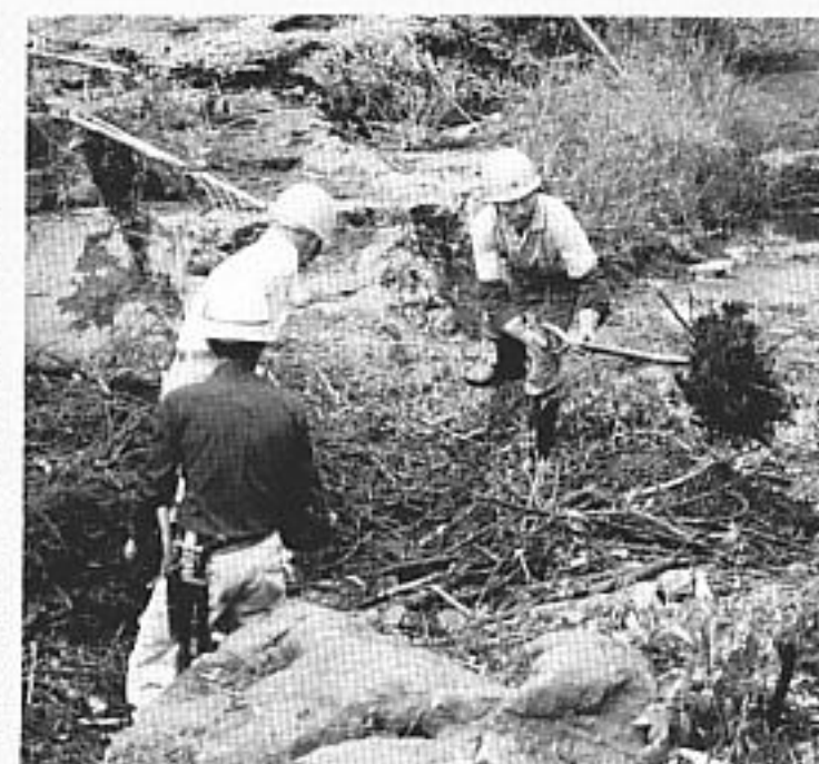
建設業協会の河川清掃
