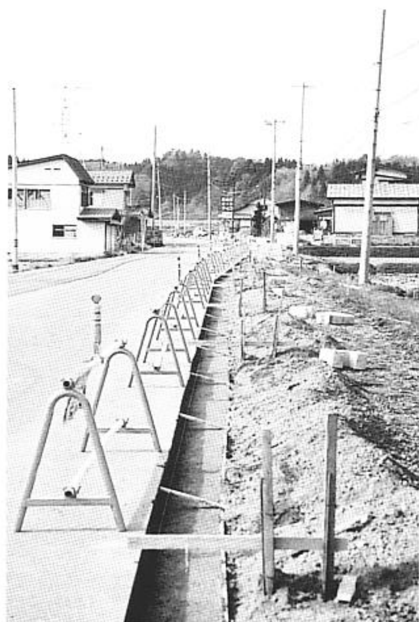
歩道設置工事が行われている町道台山線
