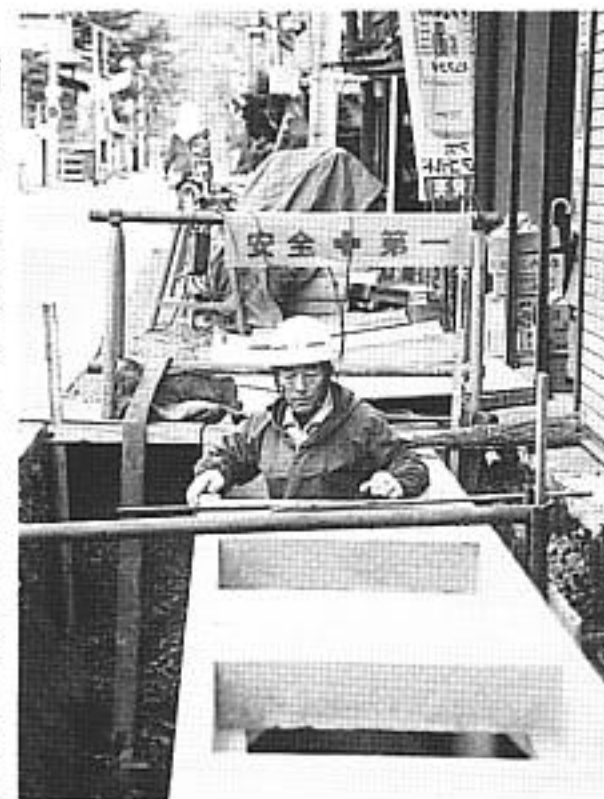
急ピッチで進められる流雪溝整備
