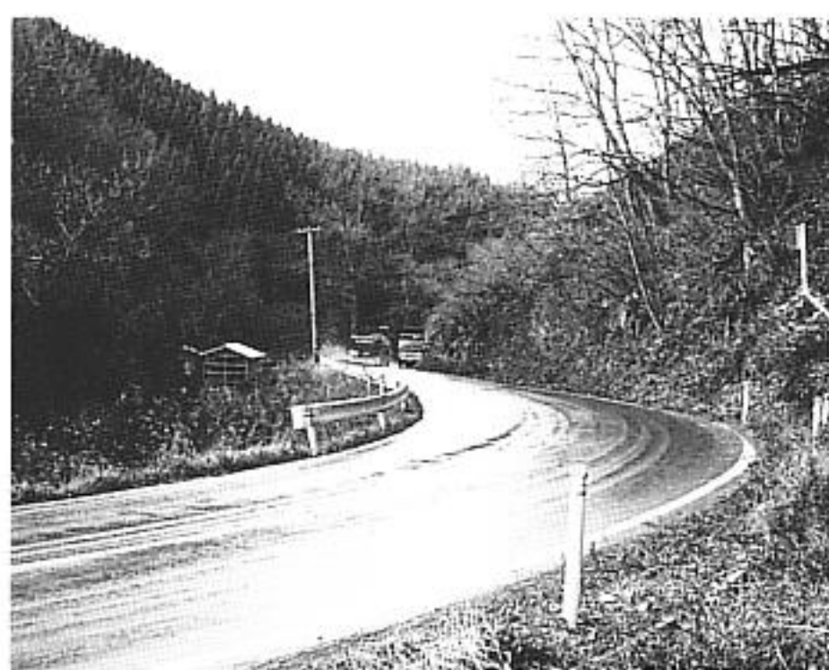
曲がりくねった道路が続く久保・板戸間。早期の拡幅が望まれる
