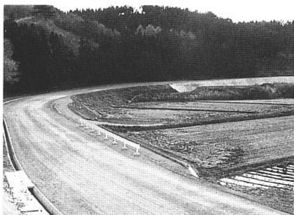
340m が改良された県道羽後向田館合線
