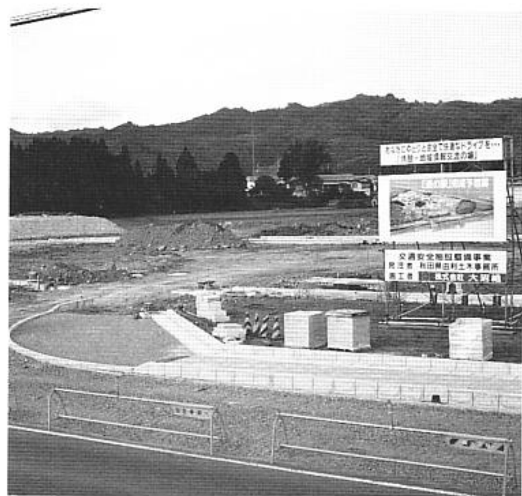
順調に工事が進む道の駅
