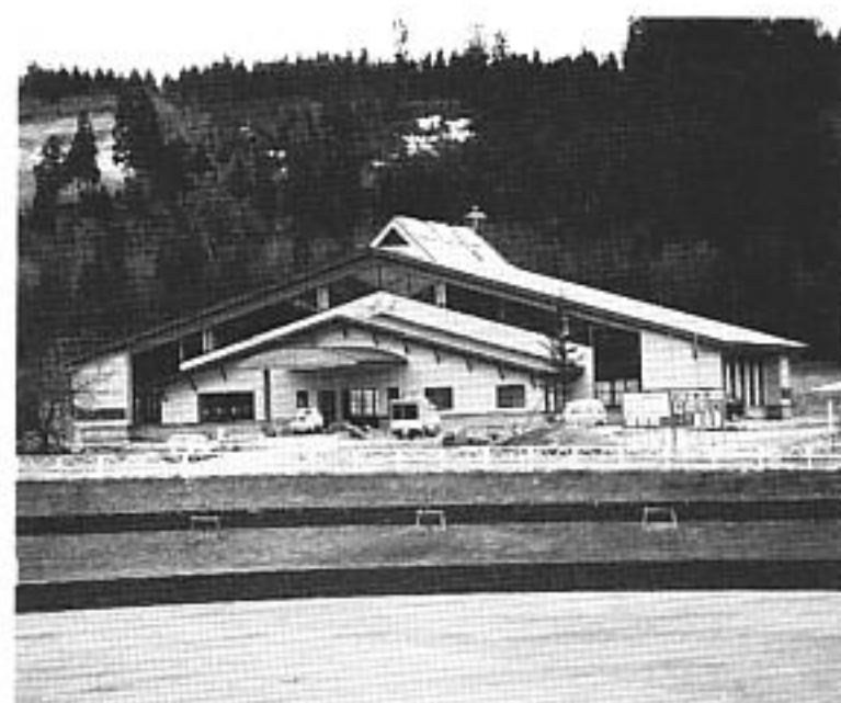
順調に工事が進む「げんき館」
