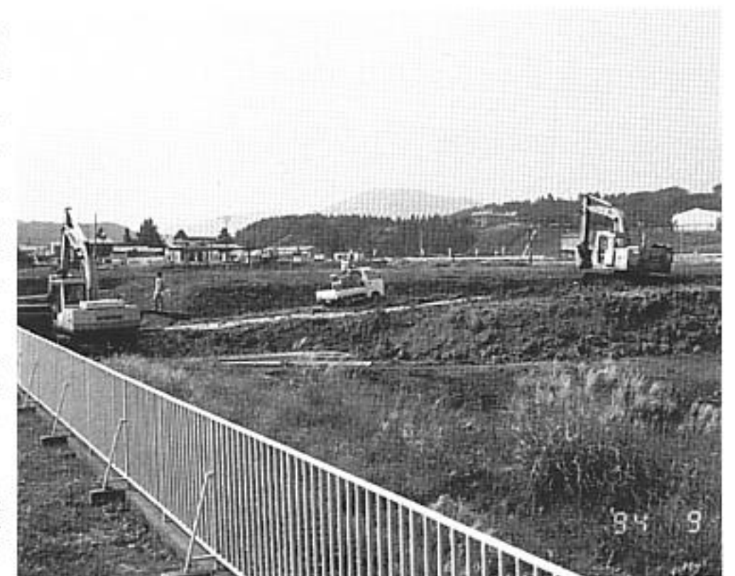
▲活性化拠点施設が本格的に工事開始
