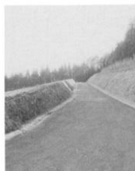
▲改良工事の完成が近い八塩2号線
