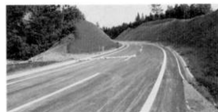
▲三ツ森山林道は450mの舗装が完成
