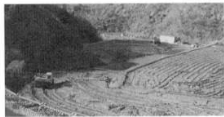
▲急ピッチで工事が進められる中の沢線
