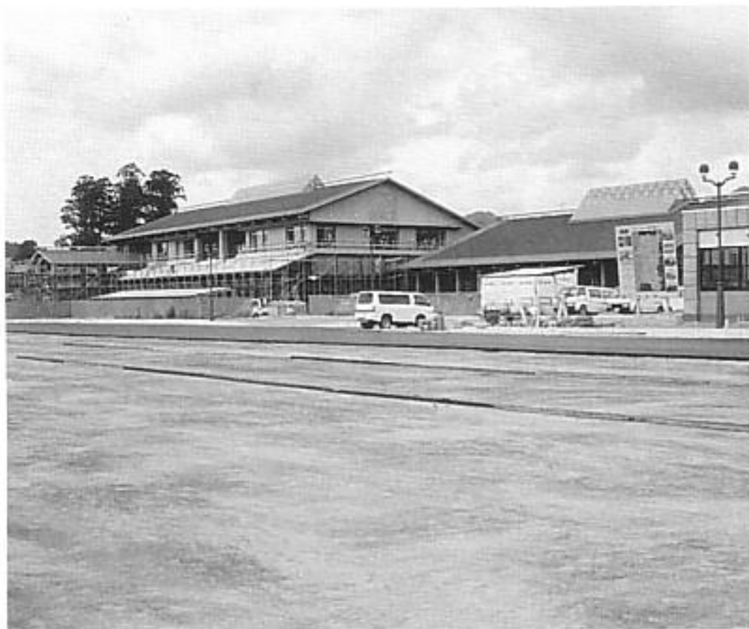
▲順調に進む施設工事
