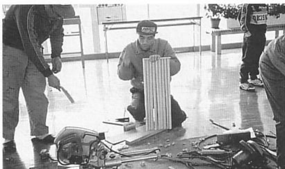
▲町建設技能組合がボランティアで学校の修理などを行った(2月4日)
