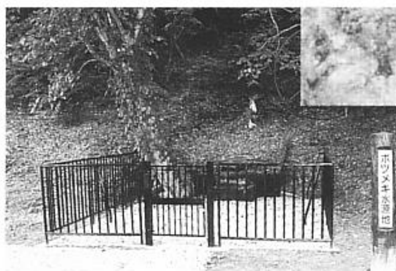
① ボツメキ水源地 水道水源の一つです。第一配水池で塩素消毒されます。
