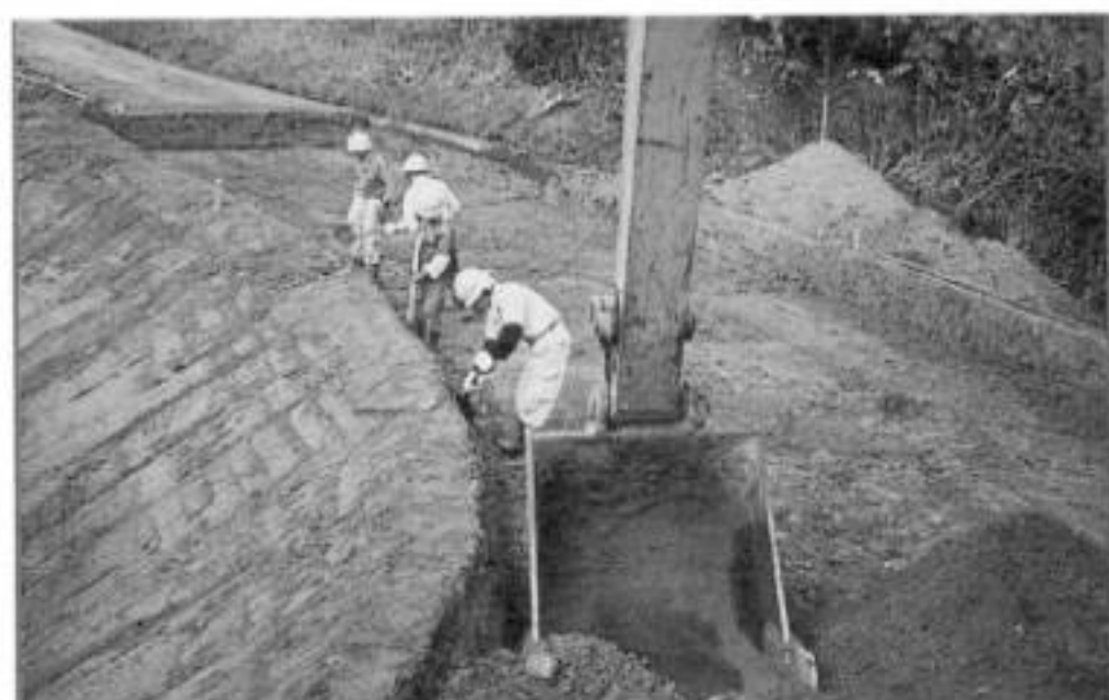
▲工事中、監督員、作業員の努力の日々
