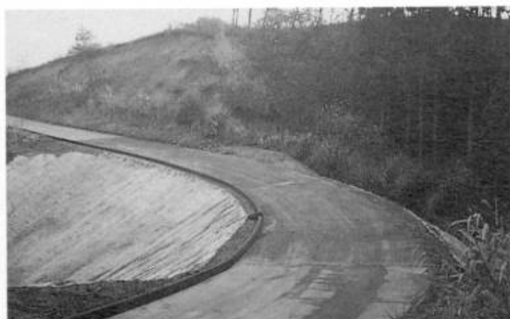
▲工事終了！工事にたずさわった方々に感謝
