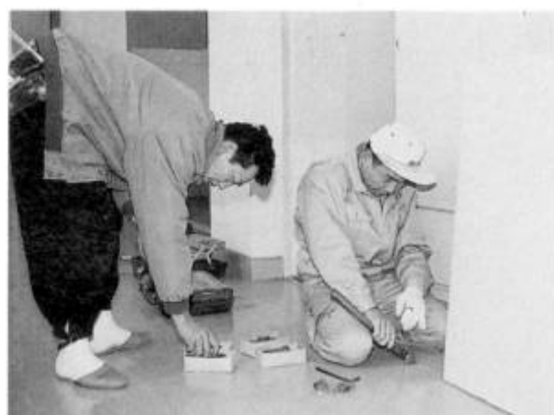
▲戸車の修理をする組合員
