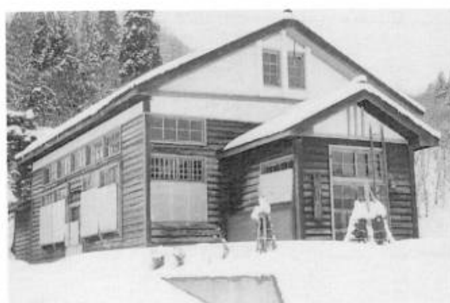
▲解体が計画されている袖山分館
