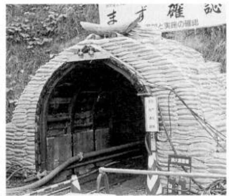
▲トンネルが開通
