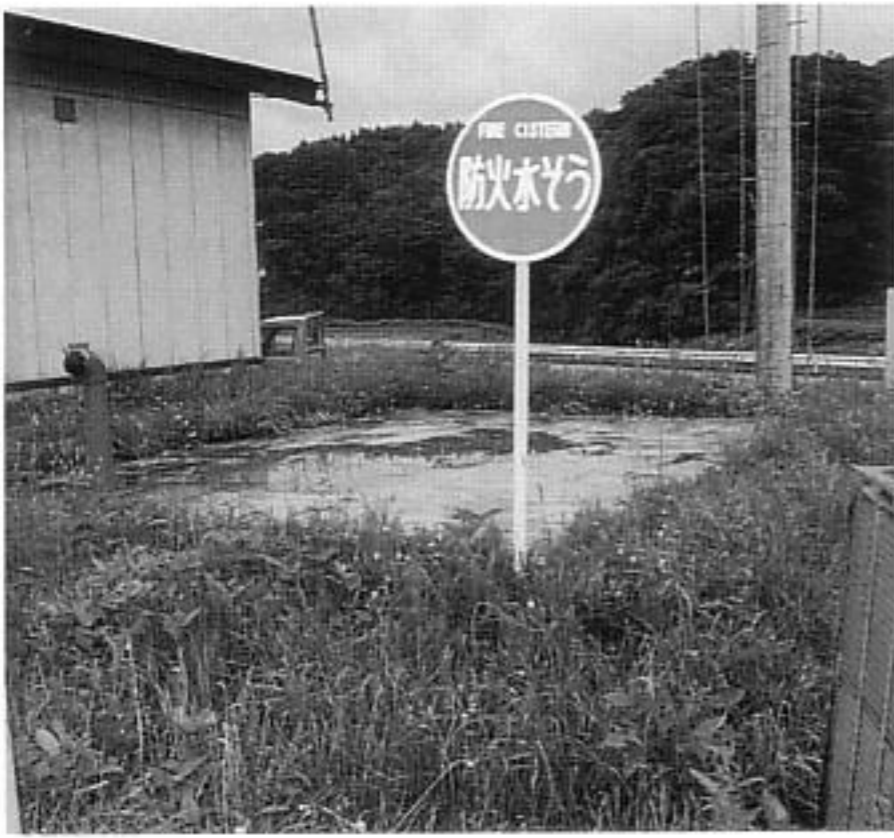
▲防火水槽設置はまず用地確保から
