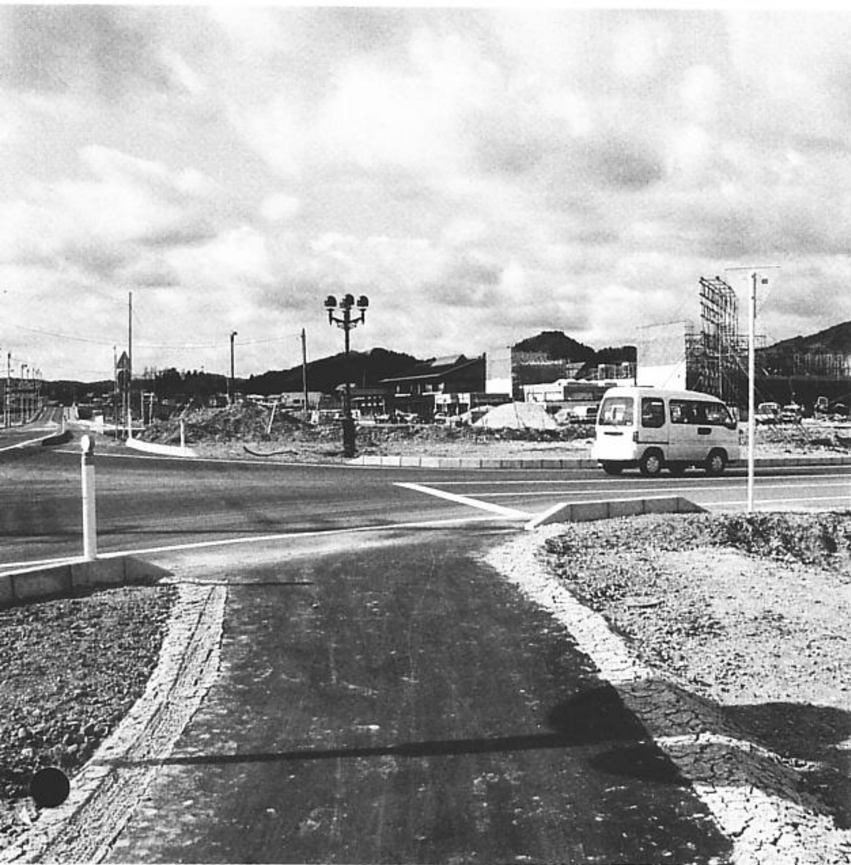
▲国道107号線との取り付け部分を舗装した町道両善寺線
