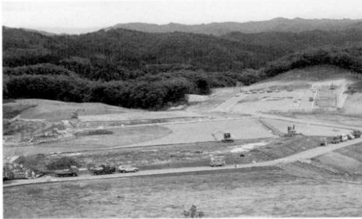
▲中山間総合整備事業で着々と進む八塩地区
