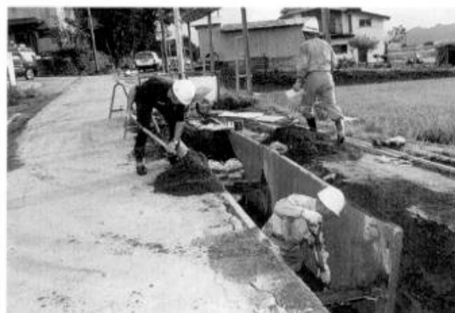
▲湯出野で行われている工事の状況
