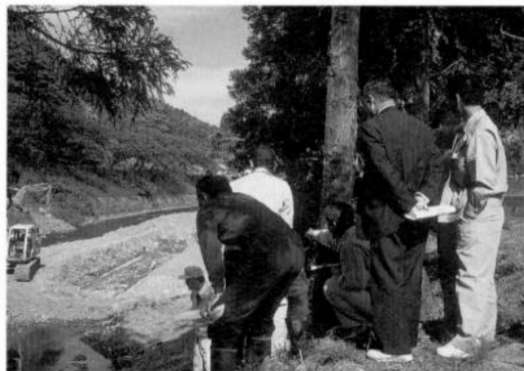
▲現場を見ながら進捗状況の説明を受ける
