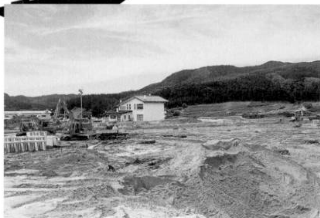
▲着々と進む宅地整備工事
