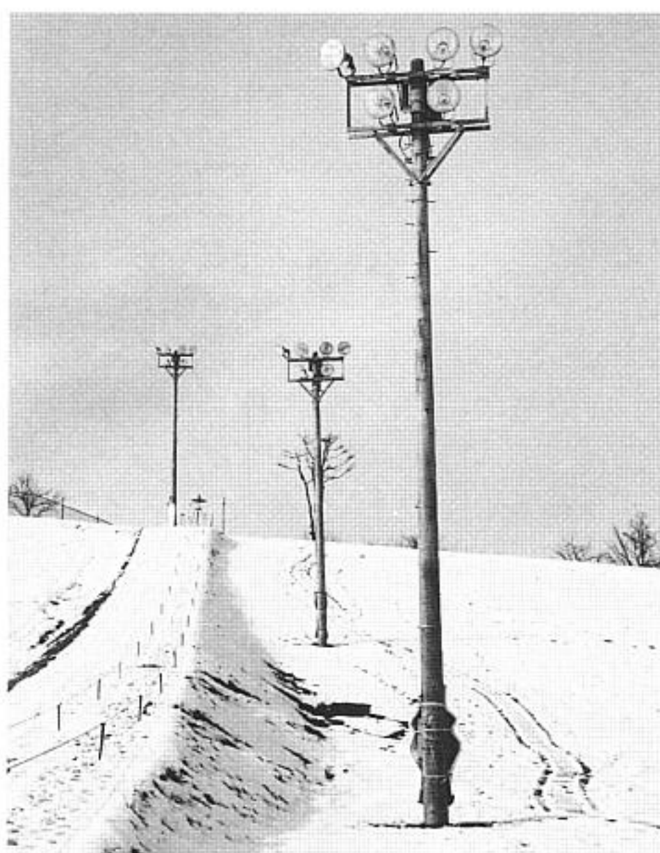
▲ナイター照明の移設工事が行われた大平スキー場
