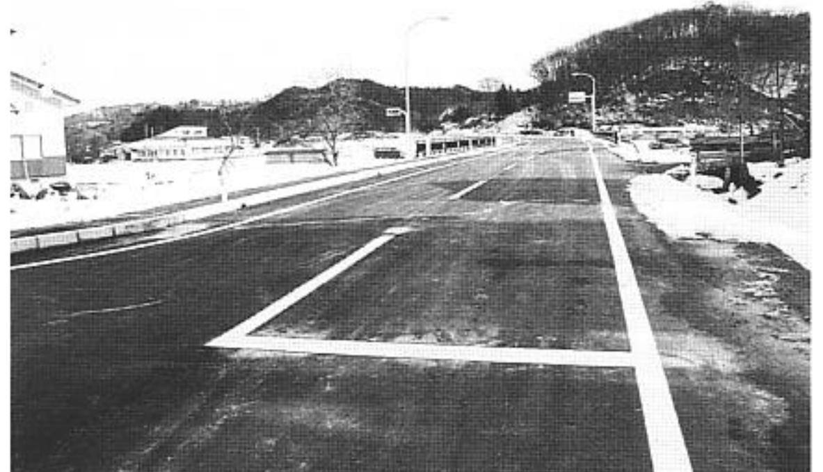
▲供用開始した館合バイパス
