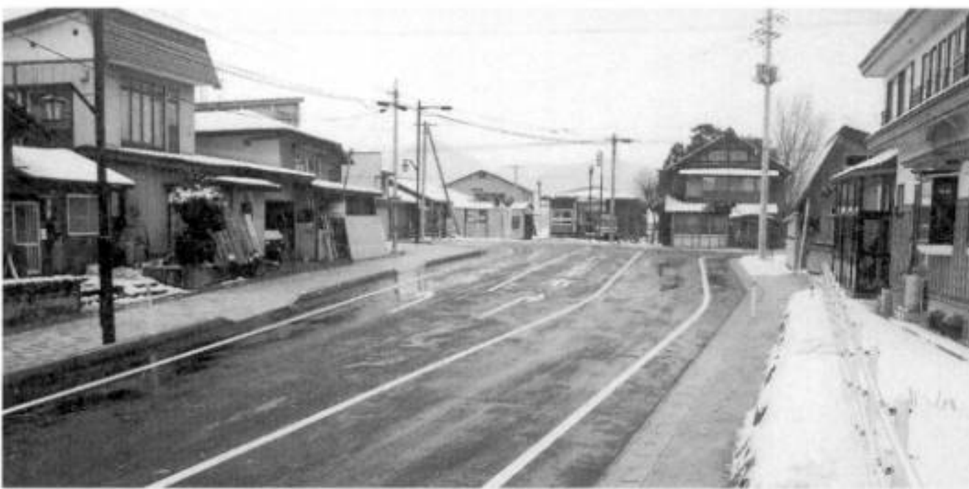
▲舗装工事が完成した両前寺線
