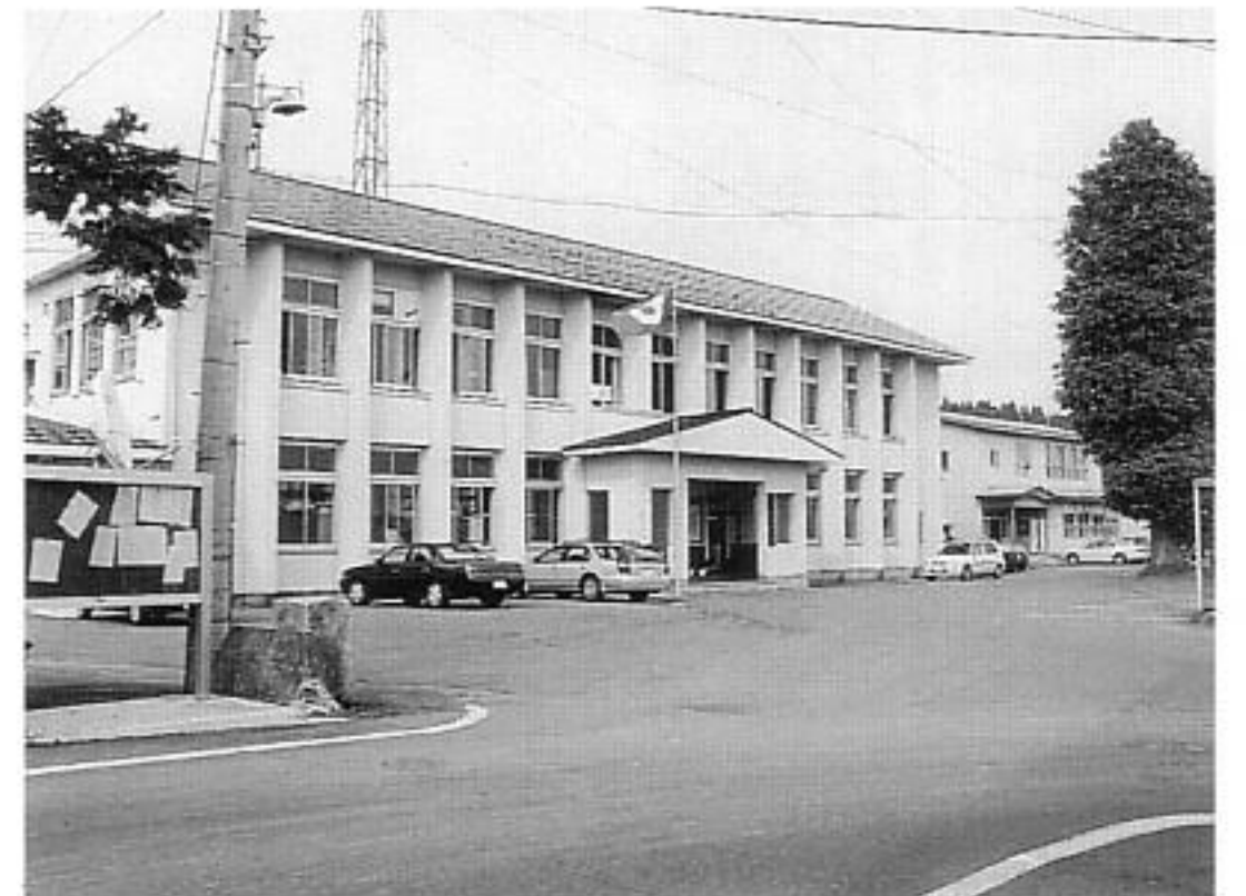
▲新庁舎建設の検討が進む役場現庁舎
