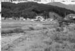
雪町側から見る石沢バイパスの路線。山肌に見えているのは1号トンネル。
