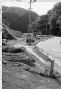
2期工区、終点となる板戸側の工事現場。平成14年度完成を目指して、着々と工事が進む。
