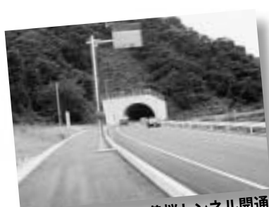
▲9/5 国道107号に黄桜トンネル開通。 平成14年度にはトンネル～板戸間 完成予定
