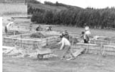
▼新校舎建築現場の様子
