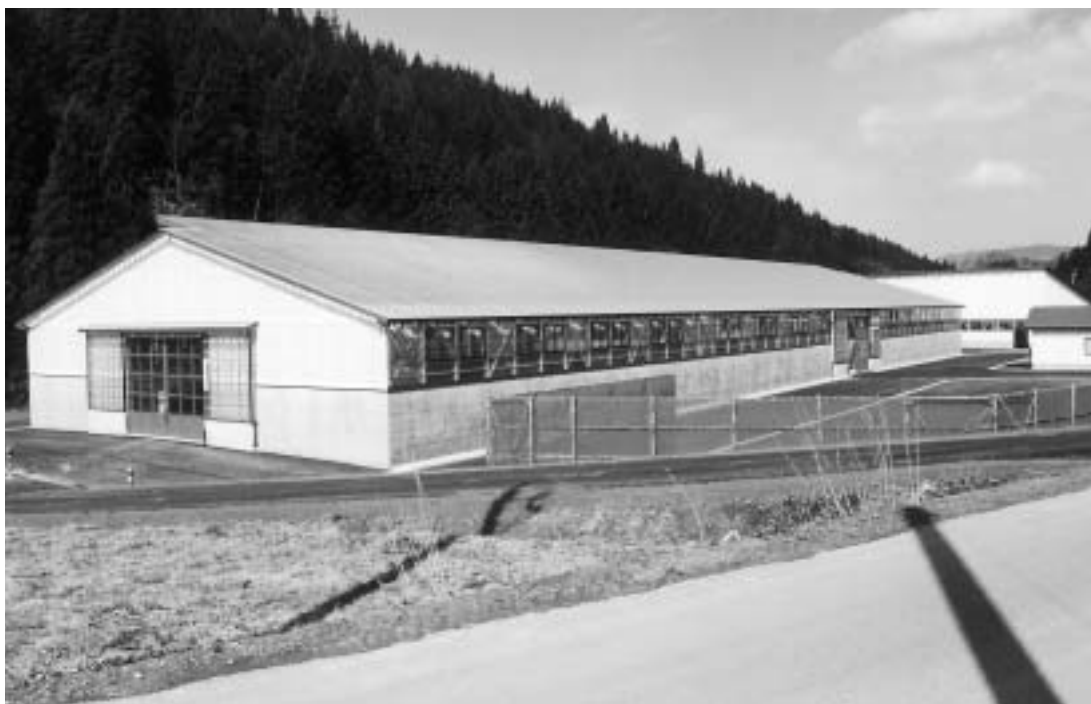
▲完成した「東由利町堆肥センター」
