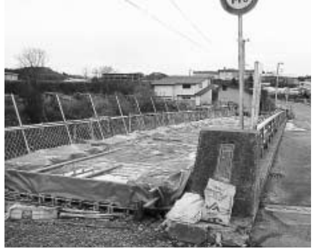
▲歩道橋設置工事が行われている台山線
