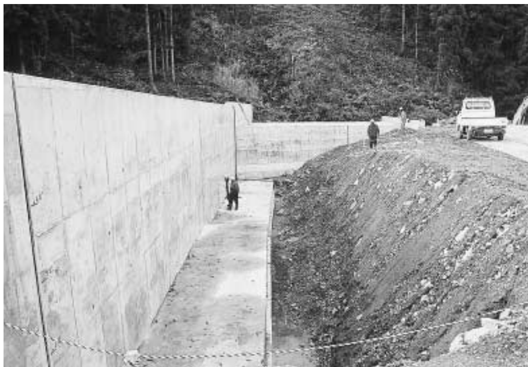
▲河川敷の確保のため5mの壁が造られた国道107号板戸工区
