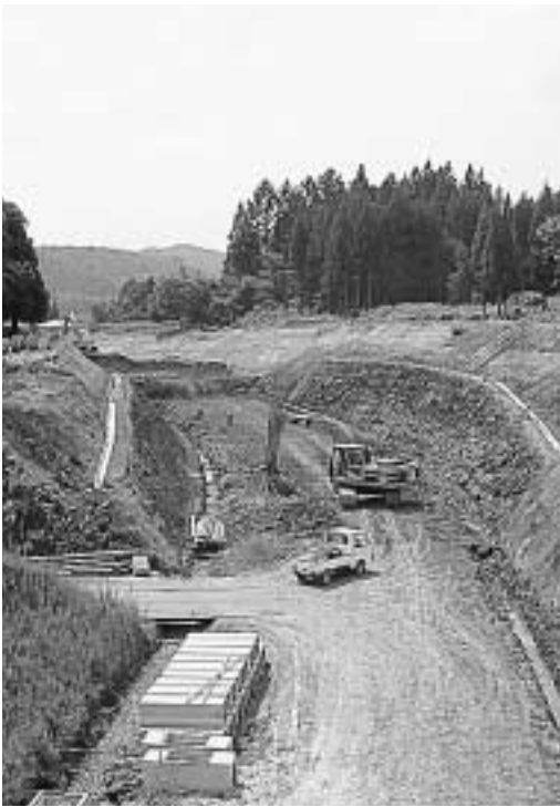
▲神岡・南外・東由利線岩館バイパスの改良工事(横渡地内)
