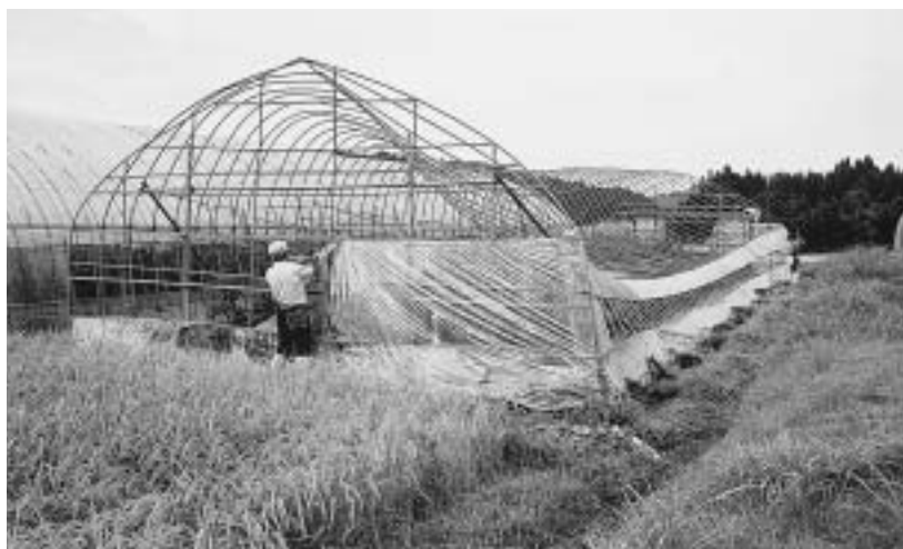
▲台風の被害を受けたビニールハウス
