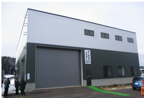
完成した秋田第2工場
