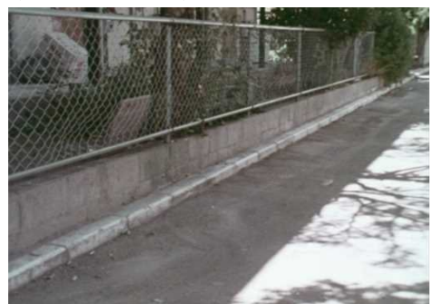
(下水道整備後)
